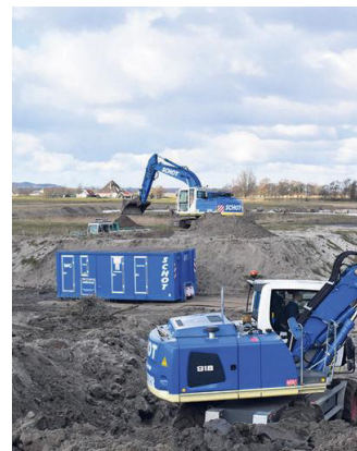
Sanering aan de Oosterdijk in Bergen.
